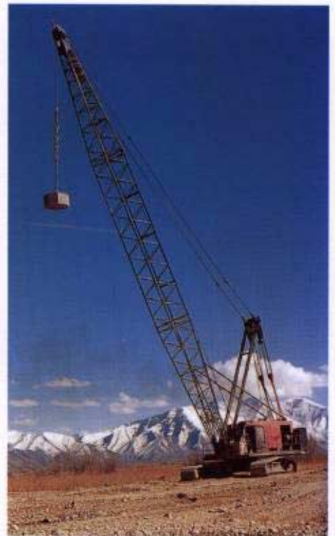
Collapsible silts, Provo, UT
